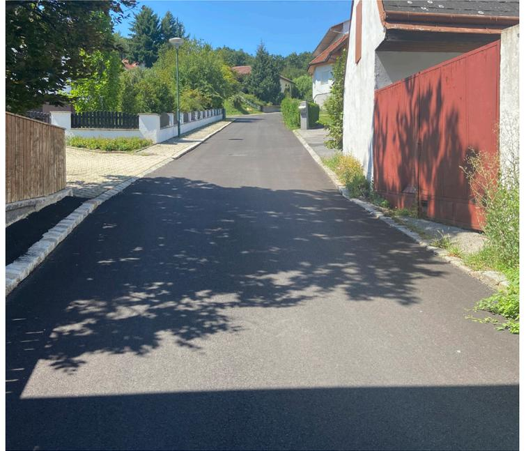
Der untere Teil des Bohnholzweges wurde vor wenigen Wochen neu asphaltiert. Im Bereich des Einlaufgitters und im Anschluss war es höchst an der Zeit zu sanieren. Gleichzeitig wurde im neuen Bereich auch die Hauptwasserleitung getauscht. So kann die neue Straße lange in diesem Zustand erhalten bleiben.
